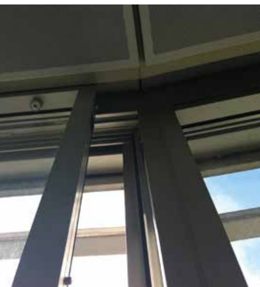
Sonderkonstruktion eines Schiebe-Systems eingesetzt in einer Doppelfassade.
