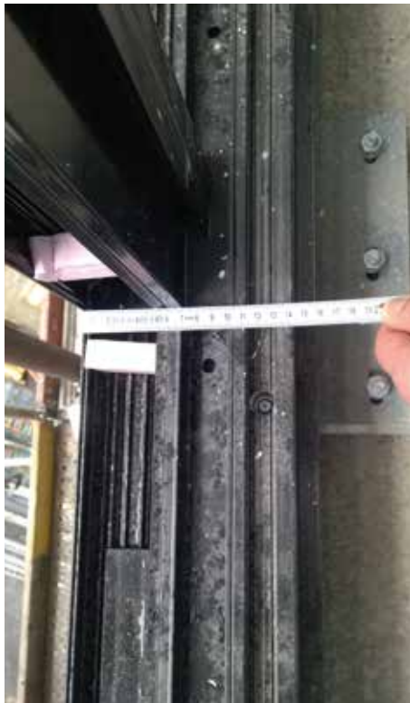
Hebe-Schiebe-System mit einer größeren Bautiefe.
