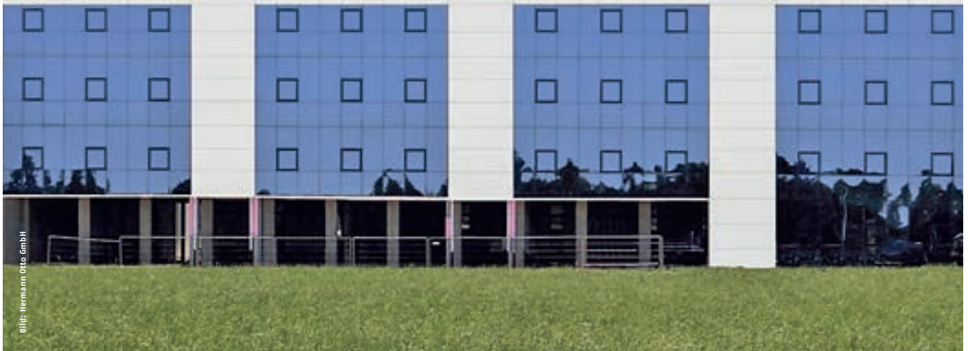
Bild 4: Das Logistikzentrum der Hermann Otto GmbH mit geklebter Holz-Glas-Fassade.
